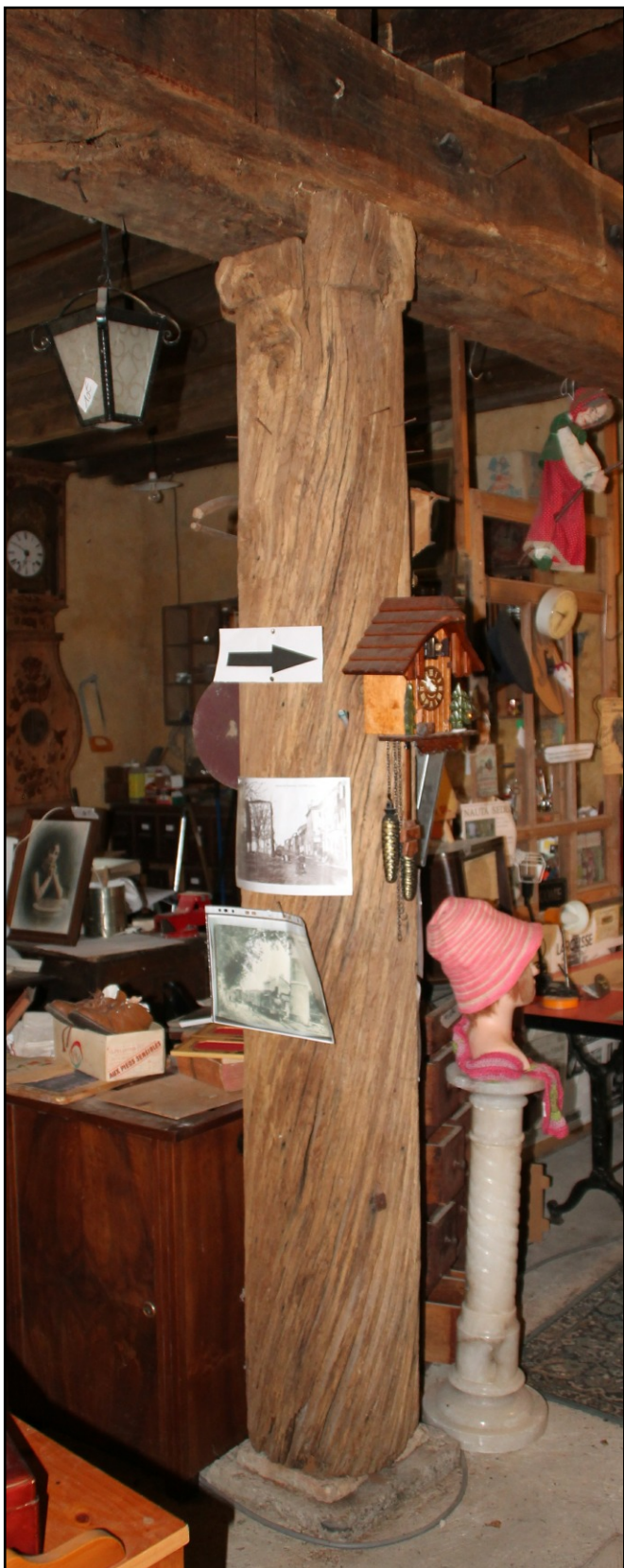
Doc. 70-71. Piliers de l'ancienne halle réemployés en soutien de poutre au rez-de-chaussée de la « tour de Malte ». Photo S.A.
