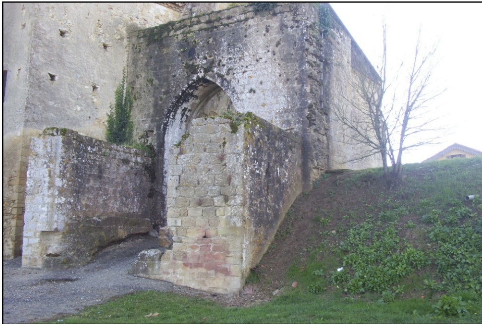
Doc. 43. Tour-porte du castelnau d'Auriébat (Hautes-Pyrénées), avec barbacane, herse et portail (mi-XV e siècle). On voit également le talus du fossé comblé que surplombait une muraille disparue. Photo S.A.
