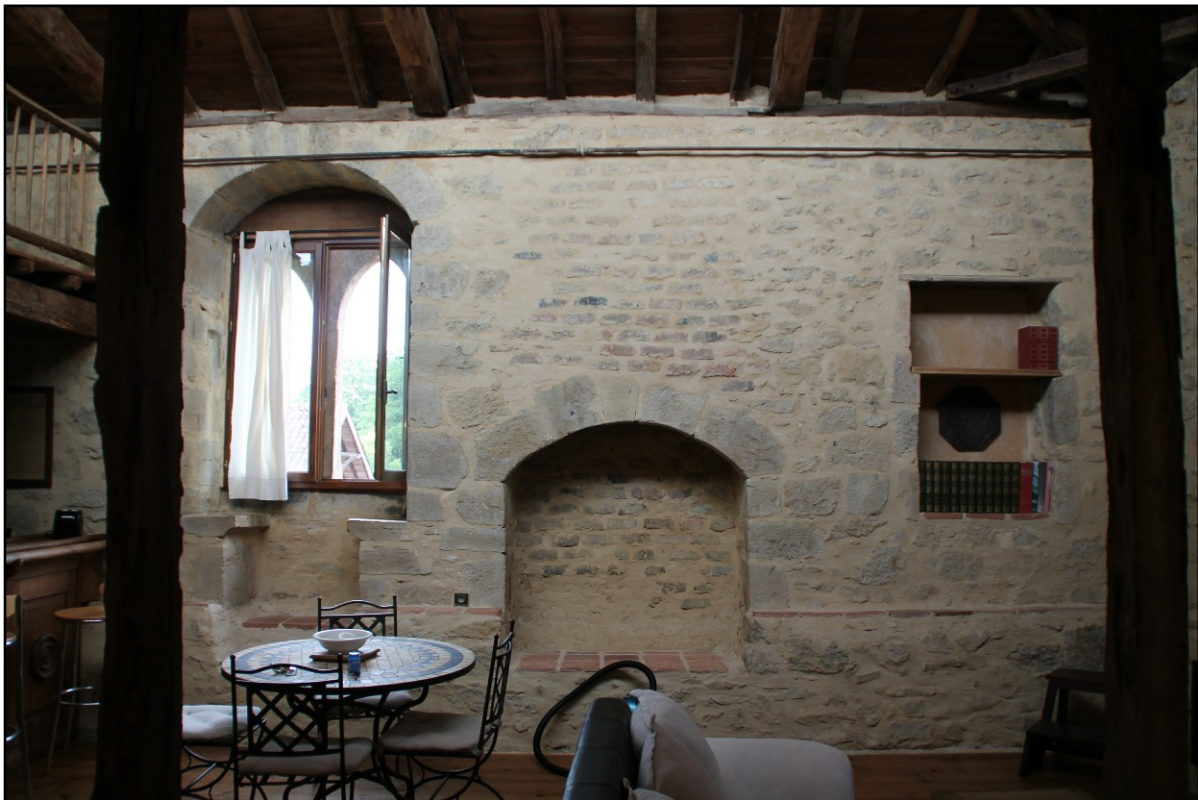
Doc. 58. Vue intérieure du second étage : fenêtre à coussièges de pierre, cheminée à conduit en « barons » de briques, placard mural tardif (XVII e s. ?). Photo S.A.
