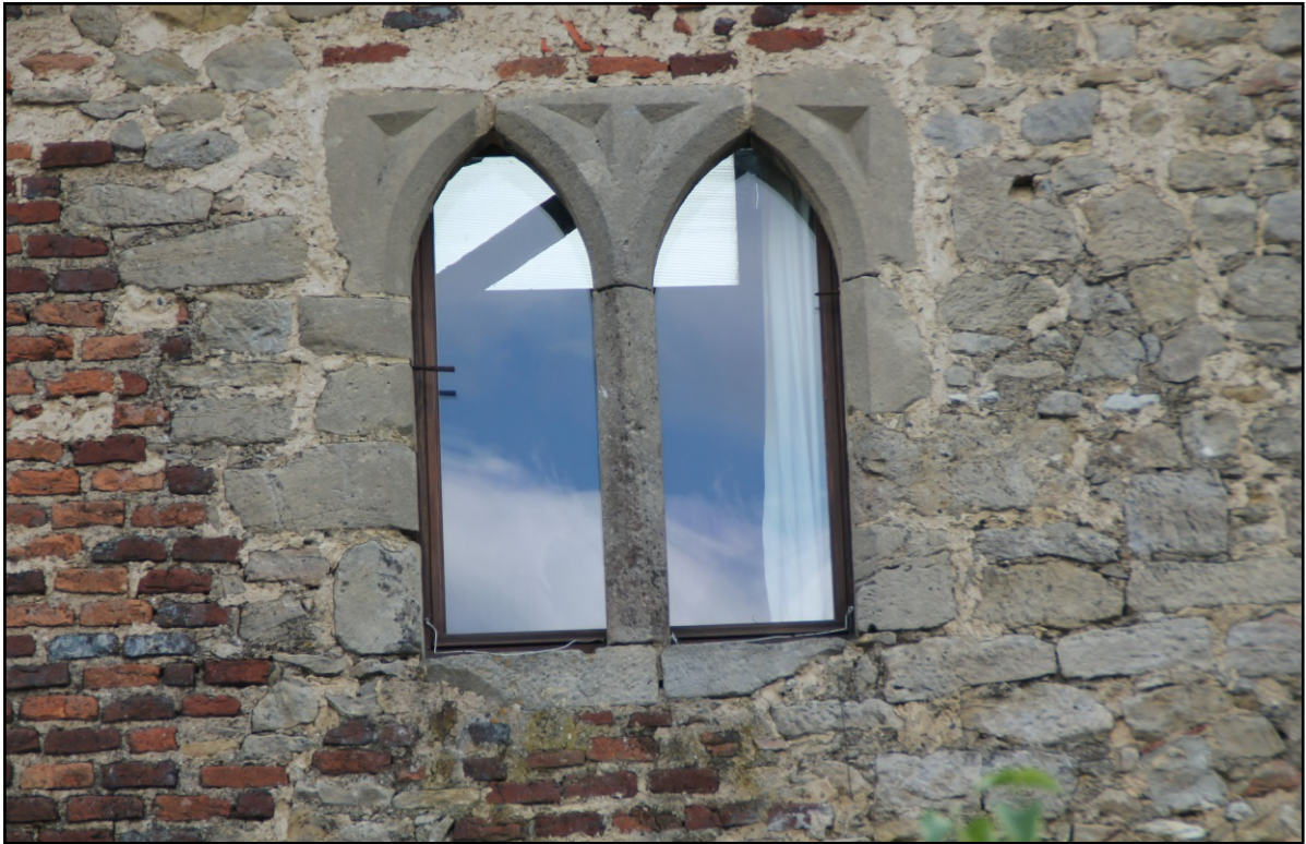
Doc. 55. Fenêtre à meneau de pierre éclairant le second étage. Les briques à gauche correspondent au fond d'une cheminée. Photo S.A.
