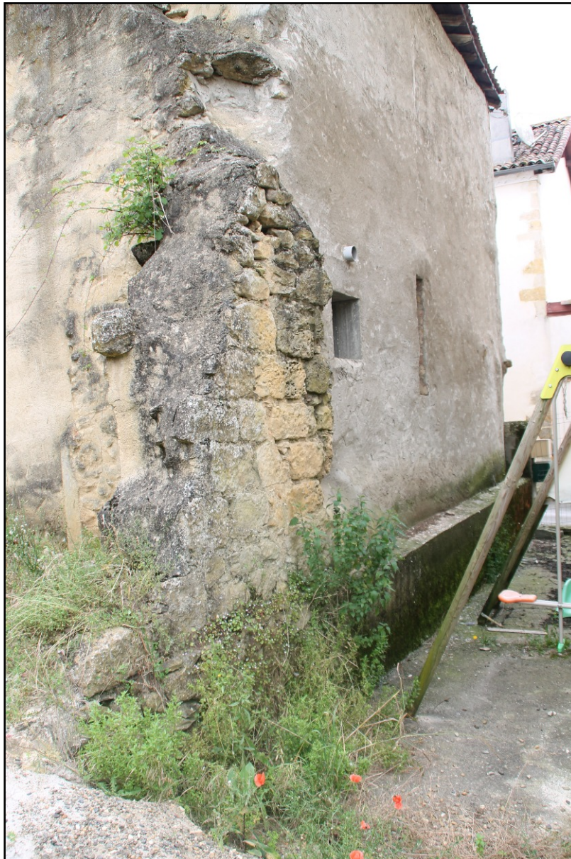
Doc. 66. Vestige d'une maison en pierres de taille à l'est de la place centrale. Photo S.A.
