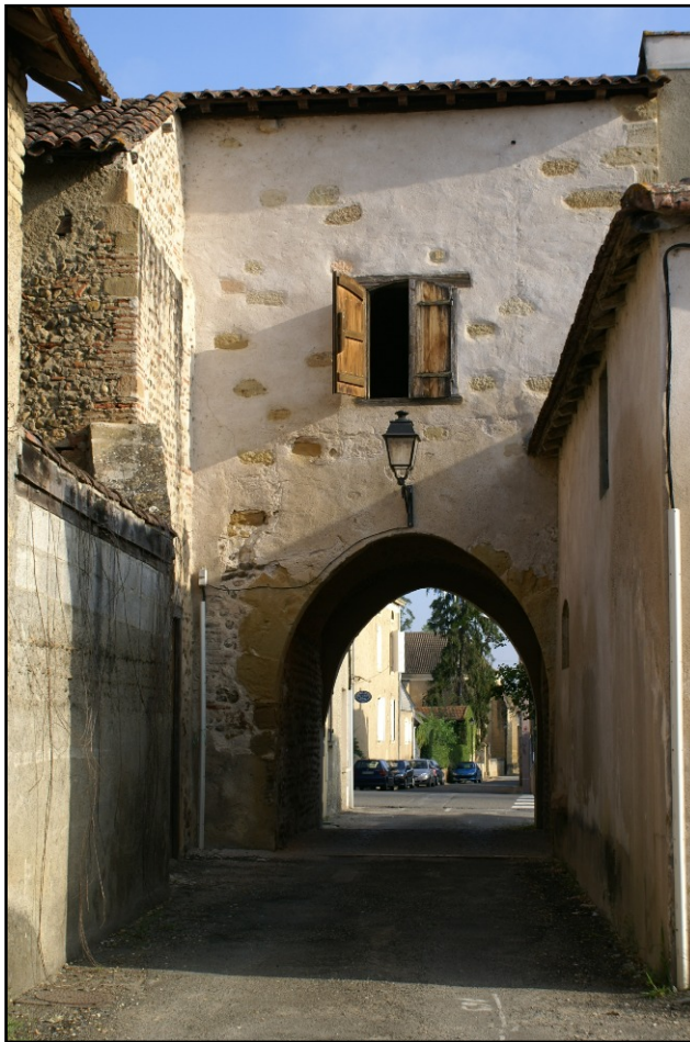
Doc. 44-45. Tour-porte du Maubourguet à Saint-Loubouer et entrée du castrum de Villecomtal-sur-Arros (XIII e s.) : emploi de blocage de pierre, portail, assommoir et vestige de barbacane disparue dans les deux cas. La muraille était formée par le revers des maisons collées à la porte, ce qui explique la présence de portes liées à un chemin de ronde mais l'absence apparente de murailles. Photo S.A.
