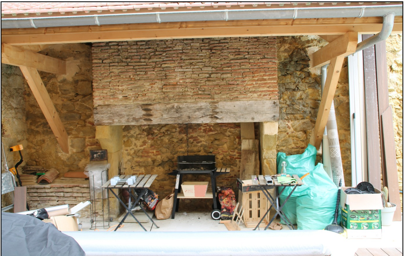
Doc. 118-119. Éléments du XVI e et XVII e siècle à l'est de la place : appui de fenêtre en remploi, cheminée. Photos S.A.
