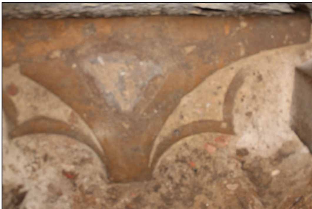
Doc. 109. Fenêtre gothique à meneau central remployé au sol au seuil de l'escalier de la tour-porche de l'église paroissiale. Plan S.A.
