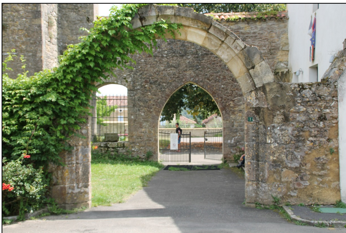
Doc. 96. Arcade de chapelle remontée à la fin du XIX e siècle pour ouvrir l'emplacement de l'ancienne salle capitulaire sur la rue. Photo S.A.
