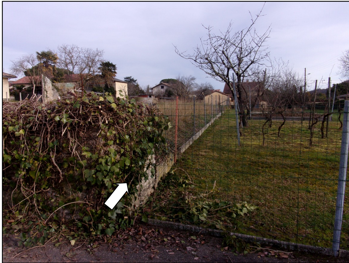
Doc. 37. F. Rue du Tuc, l'emplacement du fossé n'est plus marqué que par une limite parcellaire. Photo S.A.
