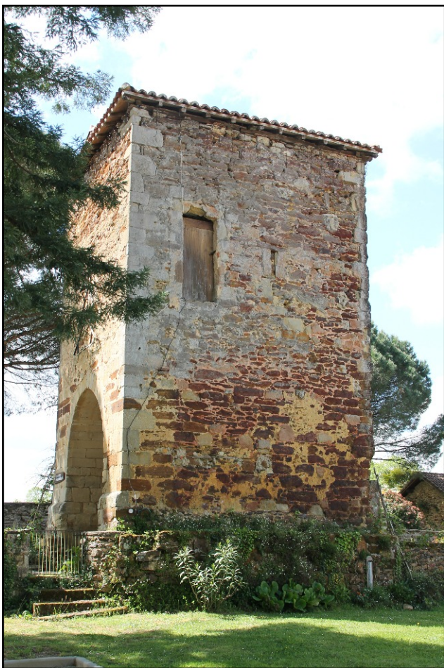
Doc. 44-45. Tour-porte du Maubourguet à Saint-Loubouer et entrée du castrum de Villecomtal-sur-Arros (XIII e s.) : emploi de blocage de pierre, portail, assommoir et vestige de barbacane disparue dans les deux cas. La muraille était formée par le revers des maisons collées à la porte, ce qui explique la présence de portes liées à un chemin de ronde mais l'absence apparente de murailles. Photo S.A.
