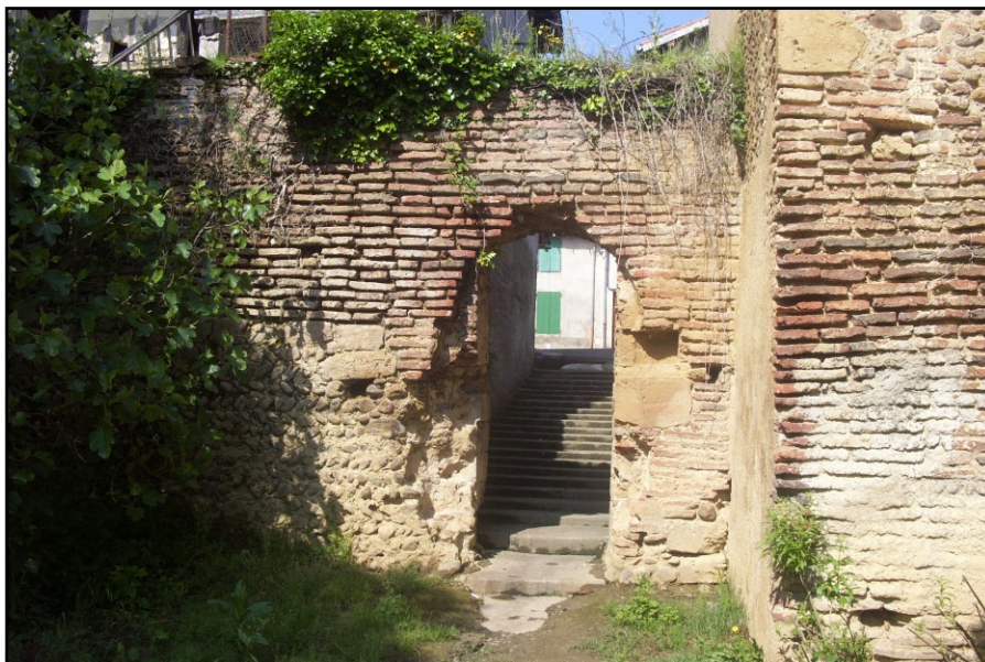
Doc. 49. Poterne de Saint-Sever de Rustan. Photo S.A.
