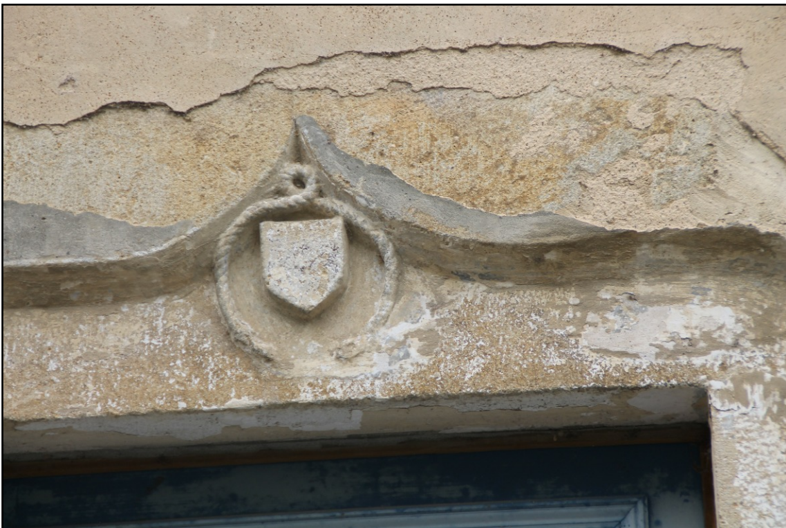
Doc. 105. Linteau gothique à écu et motif de cordelière, en remploi sur l'emplacement de l'ancien hôpital. Photo S.A.
