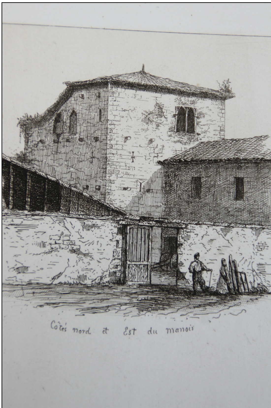
Doc. 53. La « maison forte des hospitaliers » à Geaune par le baron de Marquessac en 1866. Le dessinateur ou le graveur ont ajouté des archères cruciformes et un rang de corbeaux absents sur le bâtiment, pour en accentuer le caractère militaire. Photo S.A.
